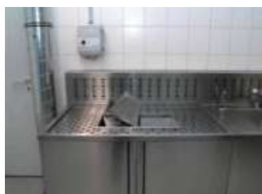
Сито вставлено для отделения формалина и твердой части
