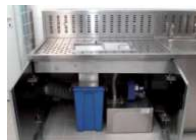
Измельчитель твердой части / 60 л бак с формалиновым насосом с автоматической системой подкачки (индивидуальное решение)
